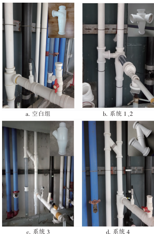
图 2 各系统所用旋流器及通气立管与排水立管的连接方式
