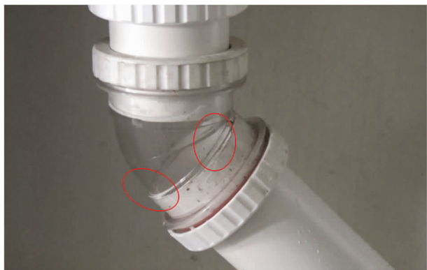
图4 系统1 通气立管根部
