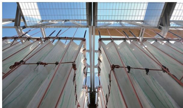
图4 生物填料布置
