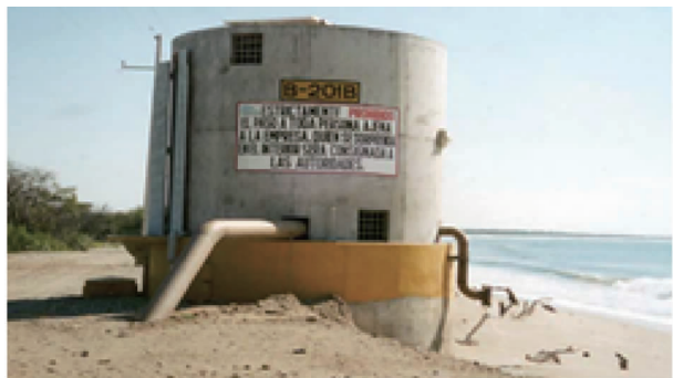
图1 海滩井取水构筑物
