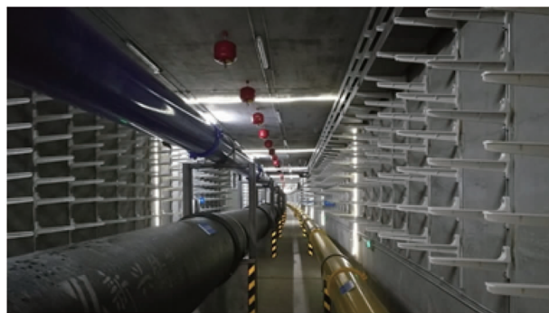
图8 管廊标准断面实际建成
