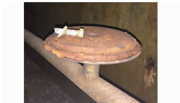
图 8 散落的曝气盘
