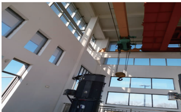
图5 取水泵房安装单梁起重机
