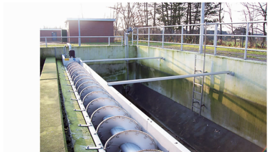
图2 安装在溢流堰后的上凹型水平格筛
