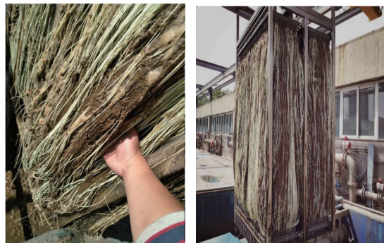
图 5 膜池污泥浓度增高引起的膜污染
