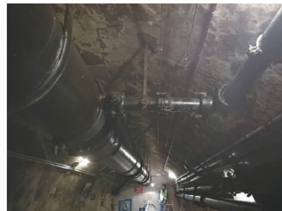
图 13 巴黎综合管廊内铸铁管道
