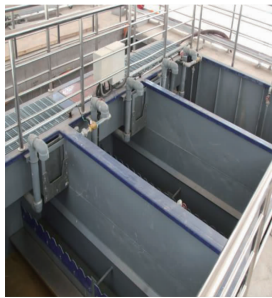
图1 Hydro-Clear 浅层高效滤池系统
