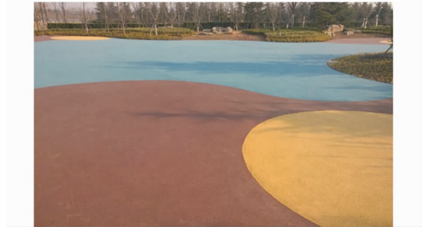
图 4 彩色透水混凝土实际效果
