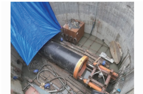
图6 工作井顶管施工
