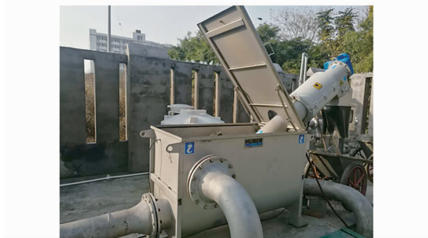
图2 精细过滤装置
