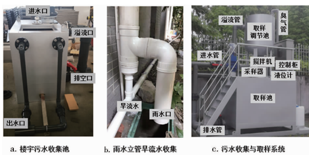
图1 污水收集计量装置
