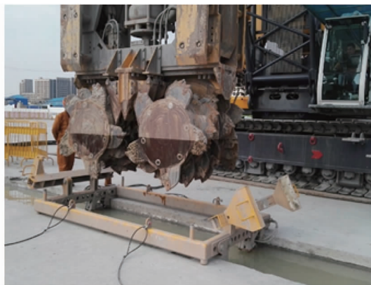
图3 搁置在导墙上的定位架
