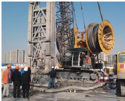
图4 铣槽施工
