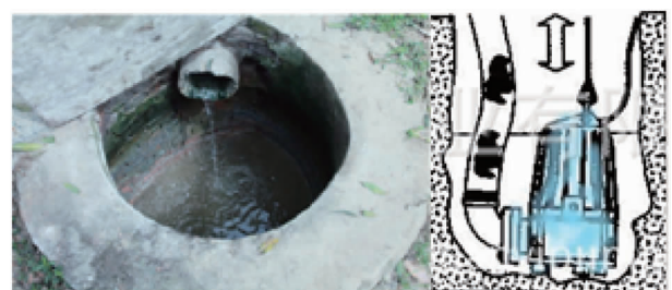
图6 院落集水坑与小型潜水泵示意
