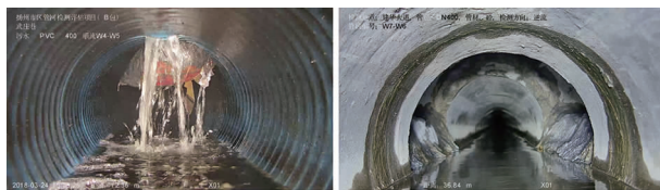
图 1 扬州市 CCTV 检测结构性缺陷高清视频截图
