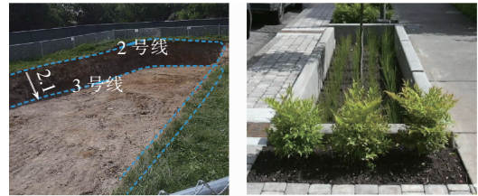
a. 自然缓坡型(空间充足) b. 直壁砌筑挡墙型(空间有限)
