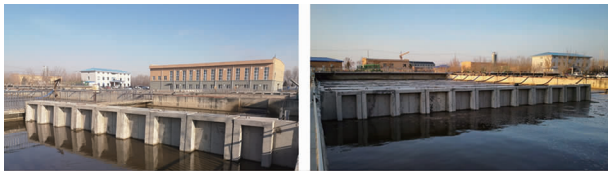
图5 A 2 O生化池预制构件拼装墙现场照片
