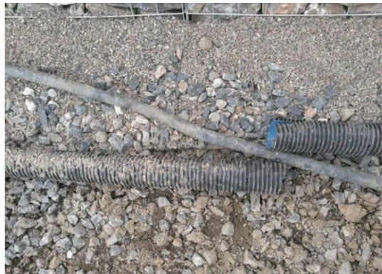
图1 透水铺装基础垫层施工错误
