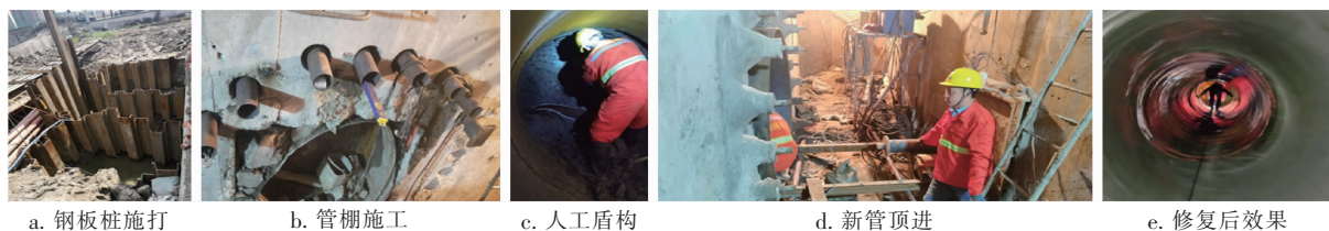
图3 CIPP 整体内衬施工过程
