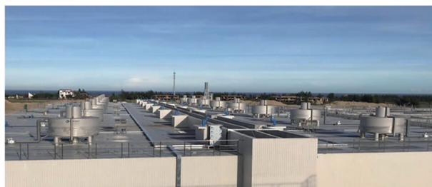
图 4 建成后的水解酸化池
