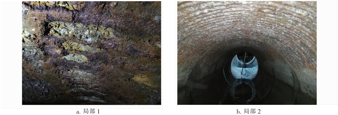
图 1 管道内壁严重腐蚀
