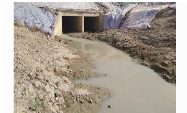
图1 工程实施前那考河膨胀性黏土造成的水体浑浊现象
