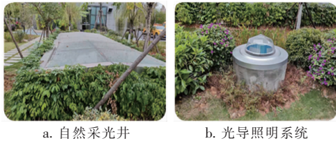
图9 采光系统实景
