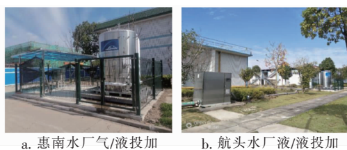
图5 \text{CO}_2 投加系统
