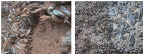
图 2 反虹涵输水混凝土面淡水壳菜侵蚀情况
