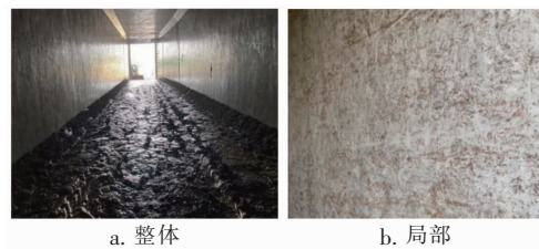
图6 通水一年后 GX - BIOX 涂料的防护效果
