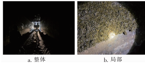
图4 防治工程施工前淡水壳菜生长旺盛
