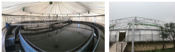
图2 原型初沉池臭气密封抽吸装置
