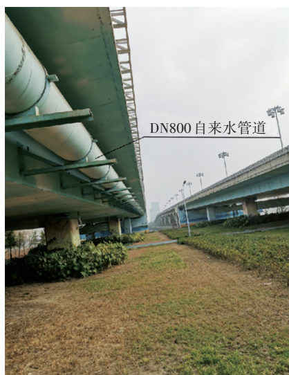
图1 广陵大桥下挂的自来水管
