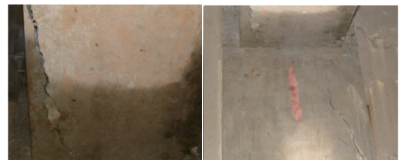
图5 梁柱节点斜裂缝
