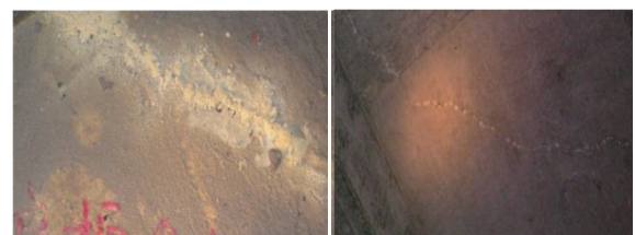
图4 顶板、底板裂缝
