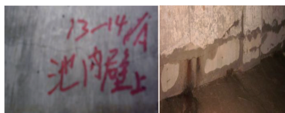
图3 壁板顶部、底部裂缝
