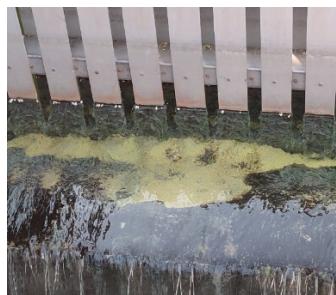
图5 出水口反洗冲出的硫磺颗粒
