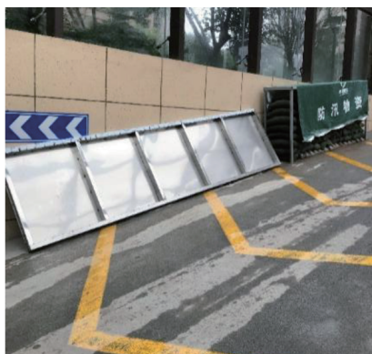
a. 某小区地下停车场出入口放置的自助挡水板和沙袋(挡水板高度1.0 m,长度5 m,两人操作,安装时间低于1 min)
