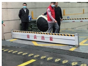
c. 某小区地下停车场出入口布置的专用挡水板(两块挡板,安装后挡板高度0.45 m,单块高度0.25 m,长度4 m。两人操作,安装时间30 s。挡板底部嵌有橡胶与地面密封)
