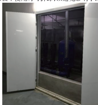
e. 地下二次供水泵房门口设置的挡水墙(高度0.5 m,本身是为防止老鼠进入)
