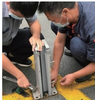
d. 路中间的挡板插槽(挡水板不使用时可拆卸,以避免影响小区交通)
