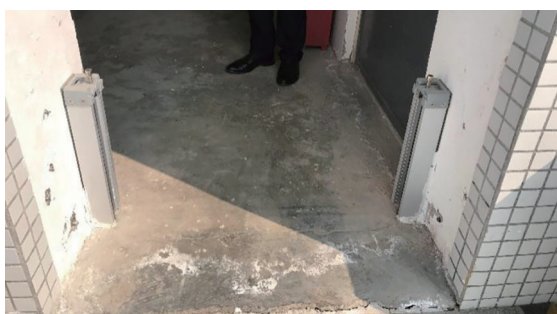
图3 人行通道出入口防洪挡板设置
