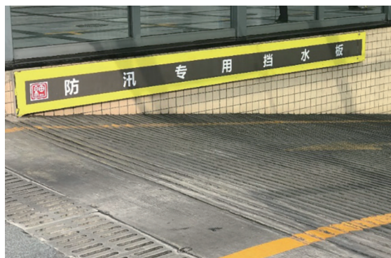
图1 某地下室出入口处布置的旋转式防汛专用挡水板
