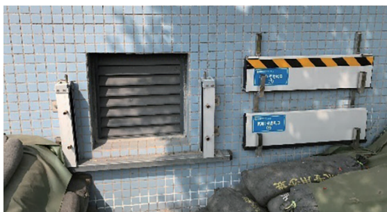
图2 地下室地面通风口防洪挡水板设置
