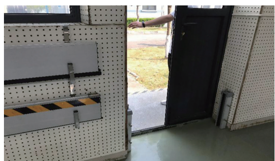
图4 室内挡水板设置
