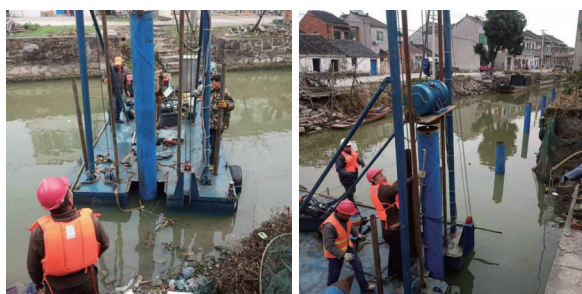
图7 钢管桩架管作业照片
