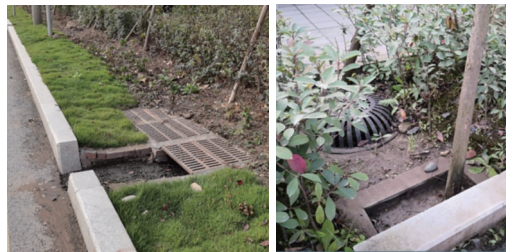
a. 重庆市某滞留带沉砂井尺寸过大 b. 遂宁市某滞留带沉砂井
