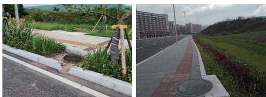
a. 某溢流口标高低于蓄水面标高 b. 后置式滞留带人行道横坡错误坡向车行道
