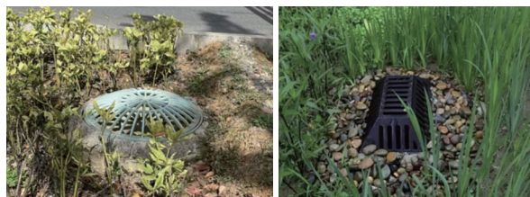
图18 上部凸出的溢流口实景
