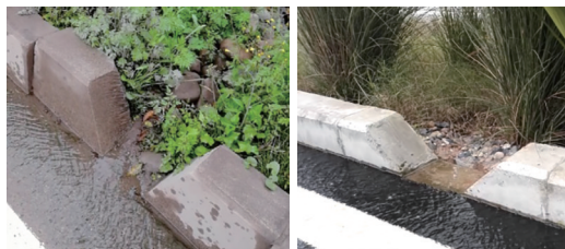
a. 重庆市某滞留带无导流措施且豁口倾倒 b. 贵阳市某生物滞留带无导流措施
