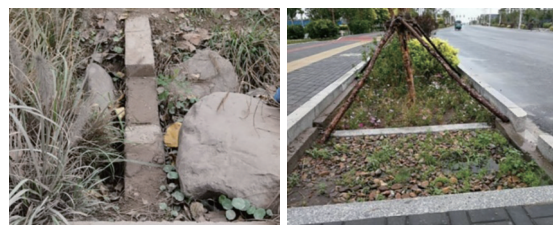
图7 生物滞留带挡水堰景观效果欠佳实景图
