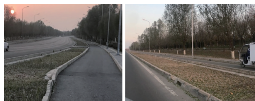
a. 北京市某生物滞留带路缘石倾倒(一) b. 北京市某滞留带路缘石倾倒(二)
