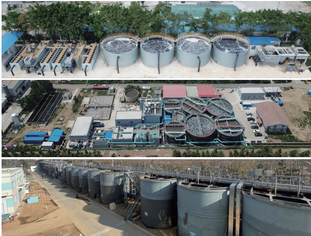
图 13 BFM 装配式污水处理设施
