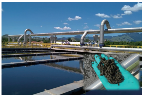
图5 Deodoro污水厂的Nereda®反应器出水堰以及颗粒污泥
