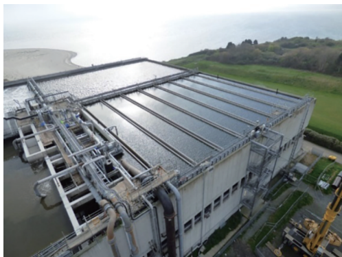
图7 Ringsend污水厂现有SBR单元改造为Nereda®反应器
