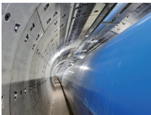
图3 盾构隧洞内置钢管建成实景
