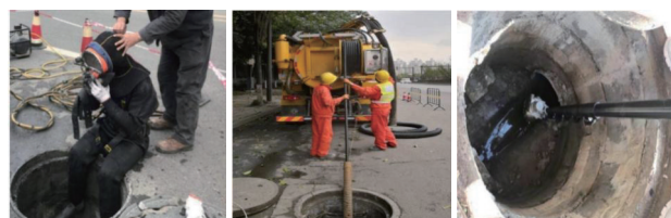
a. 封堵作业 b. 清洗疏通 c. 管道检测
