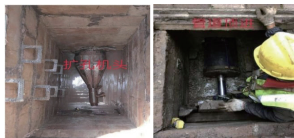
a. 导向扩孔管顶进 b. 钢套筒顶进
