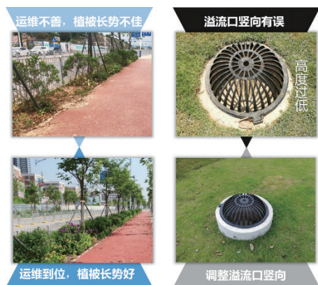
图12 某项目巡查整改前后海绵设施效果对比
