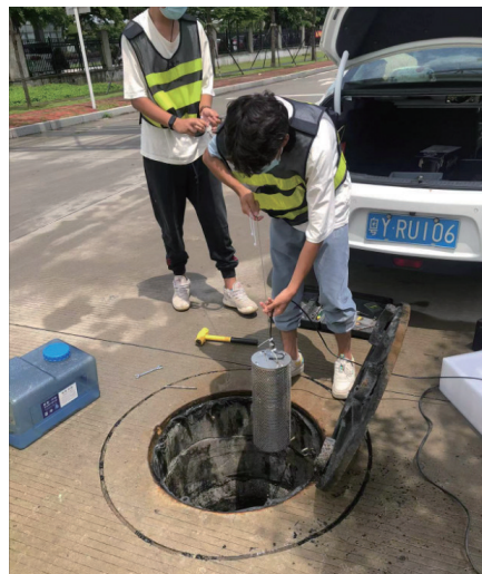
图1 在污水井中安装在线监测仪表
