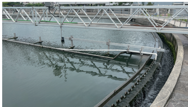
图4 投加含氯中水抑制青苔及藻类生长
