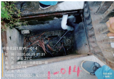
a. 住宅小区 A 污水接入雨水算
