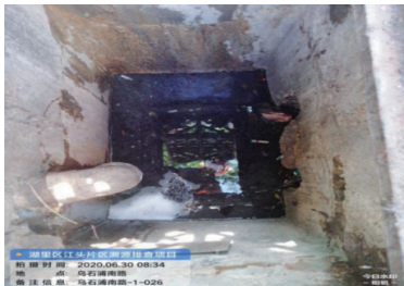
d. 乌石浦南路污水接入雨水检查井
