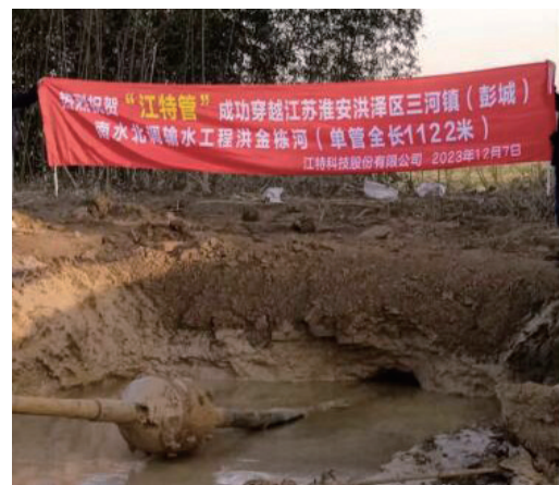
图 8 牵引施工成功穿越现场实景
