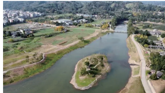
图5 夹关段生态堤防工程
