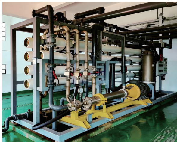
图6 反渗透撬块与能量回收一体机工程现场
