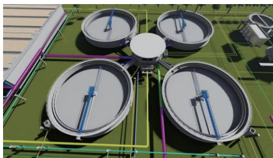
a. 二沉池及地下综合管线
