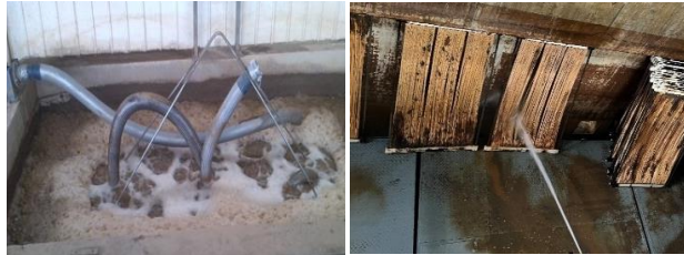
图4 MBR工艺膜组件清洗
