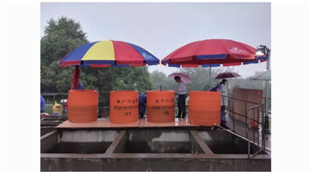
图 10 河下镇水厂应急净水药剂投加设备
