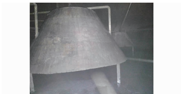
图2 IC反应器布水罩
