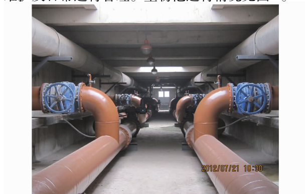
图2 生物池管廊布置
